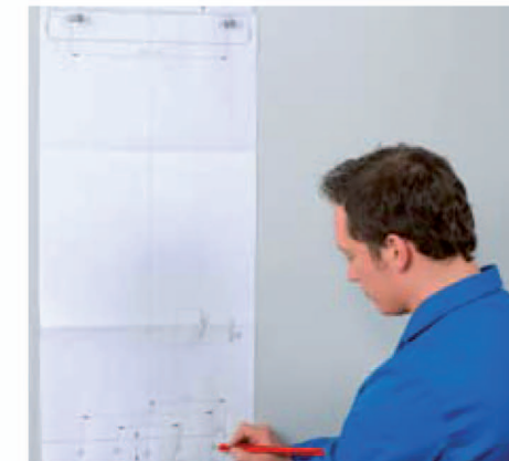
۱- استفاده از الگوی نصب قبل از نصب دستگاه
